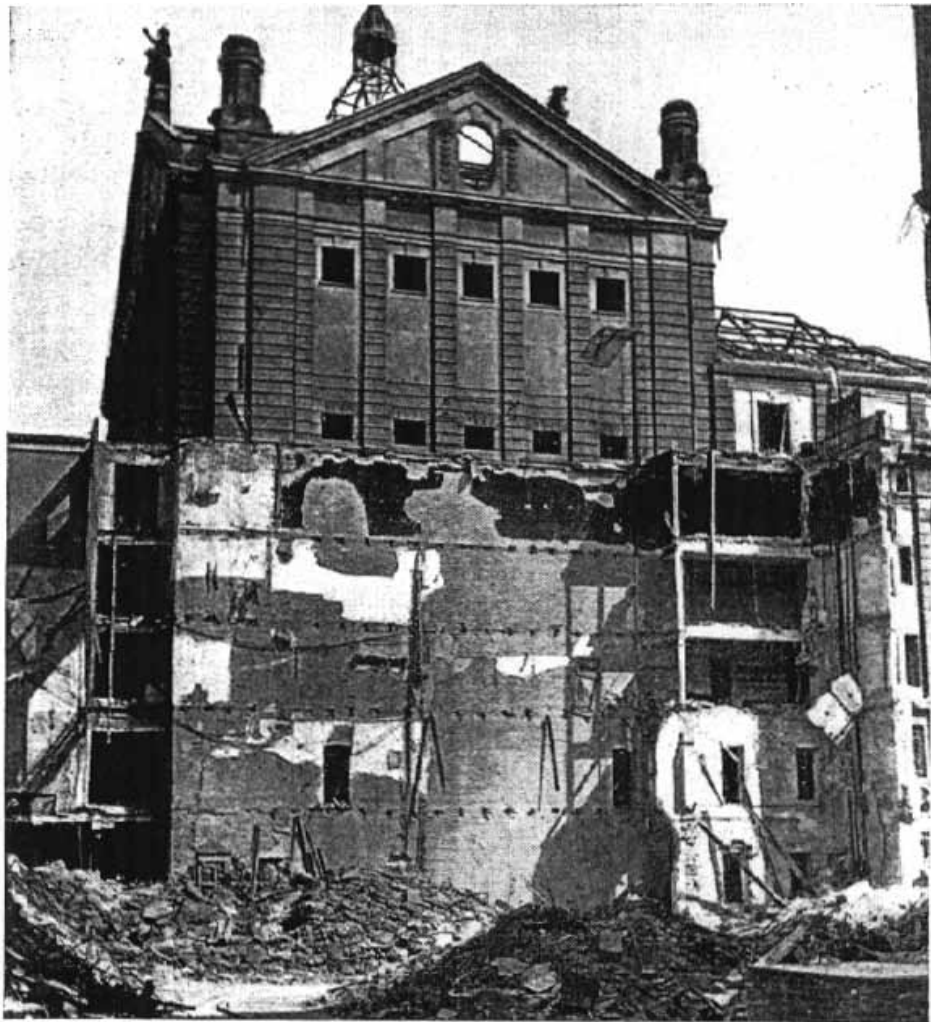
Südseite des Opernhauses nach dem schweren Sprengbombenunglück am 14. Mai 1944, 23,55 Uhr.
